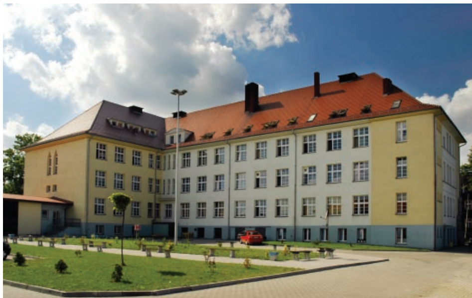
Nasza Szkoła w czasie ostatniego remontu i obecnie
